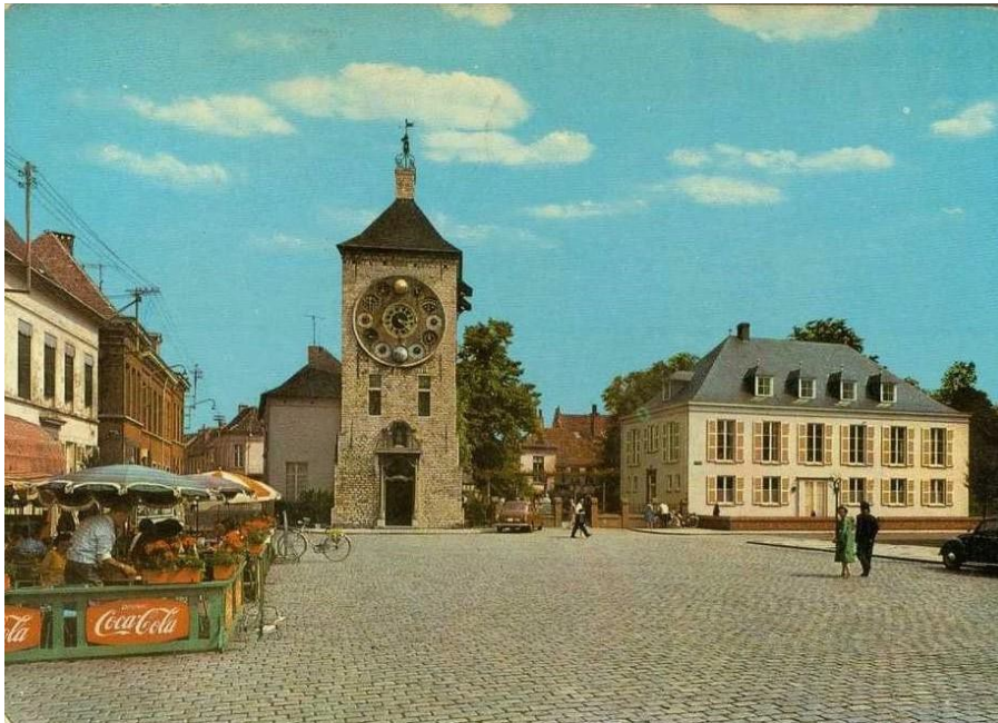
Voormalig (ca. 1960) zicht op het huidige Zimmerplein, gezien vanaf de Gevangenpoort. Achteraan zien we de Zimmertoren. De waterloop is al lang gedempt en de fabrieken werden gesloopt. De ruimtelijke herinnering aan de economische bedrijvigheid is gewist ...
