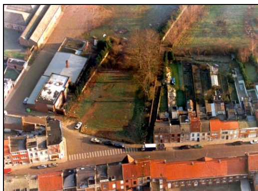
Luchtfoto van de Albers site aan het Achterstreutje (Rivierstraat), het Hof van Albers 2 was al afgebroken.
